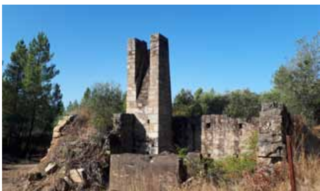
Fig. 11 – “Torre do seixo”: a maquinaria aqui instalada para triturar os seixos em bruto e fazer saltar o minério provocava um barulho ensurdecedor. «Perfurava os ouvidos, os ossos, tal uma verruma» (p. 44).
