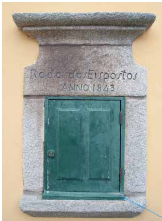
Roda de expostos vista do exterior
